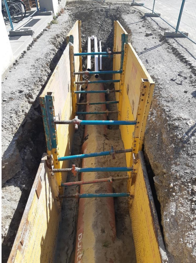
Caisson métallique type Krings
