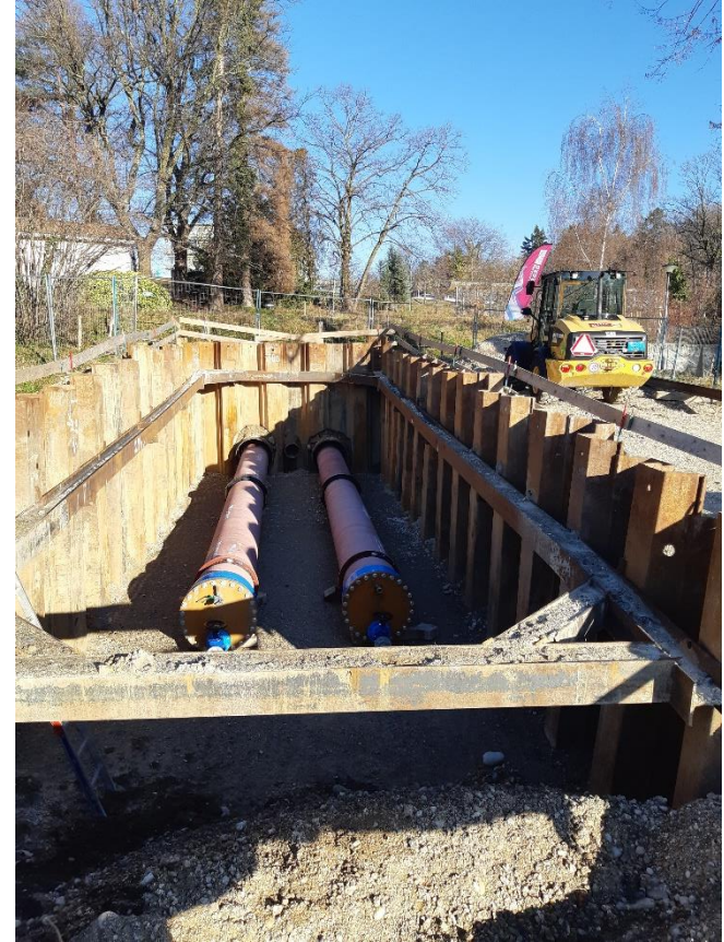
Battage de palplanches
